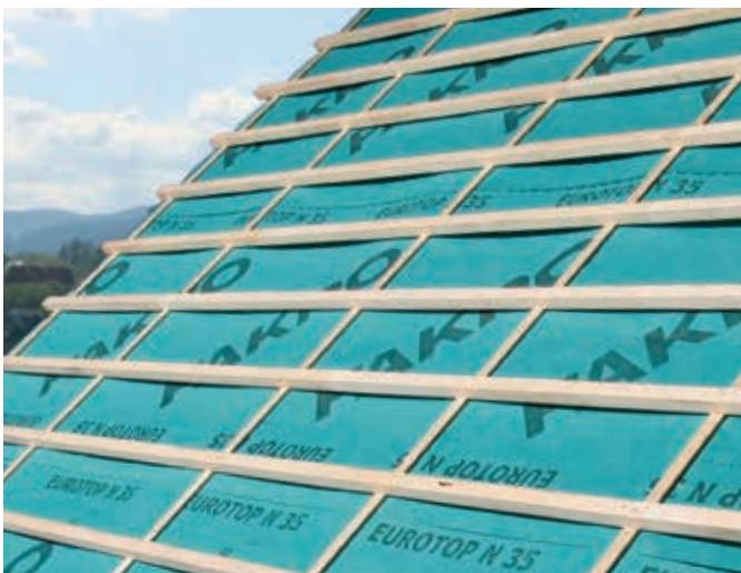
Диффузионные пленки характеризуются уникальным сочетанием таких параметров, как сопротивление водяного пару и пропускная способность. Высокая паропроницаемость диффузионных пленок защищает конструкцию и теплоизоляцию кровли от:
