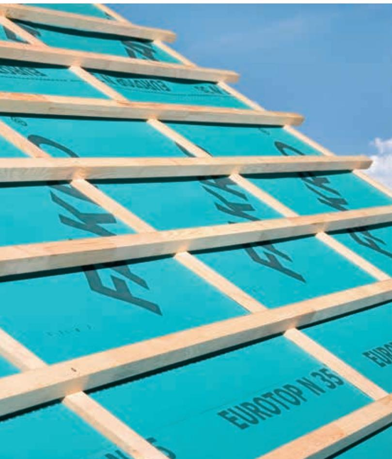
Диффузионные пленки представляют собой первый подкровельный слой. Этот слой улучшает герметичность, защищает теплоизоляцию от влаги и является важным элементом системы изоляции скатных крыш.
