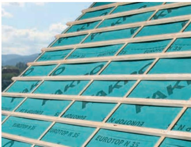
Диффузионные пленки характеризуются уникальным сочетанием таких параметров, как сопротивление водяному пару и пропускная способность. Высокая паропроницаемость диффузионных пленок защищает конструкцию и теплоизоляцию кровли от:
